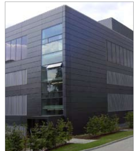
Auch beim Uniklinikum in Frankfurt am Main kommt eine Pulverbeschichtung mit chromfreier Vorbehandlung zum Tragen.
